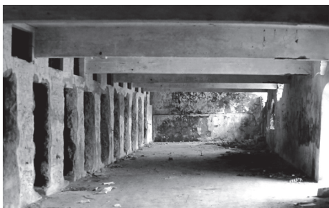
Interior da área das celas no subsolo da Colônia Penal Cândido Mendes (CPCM), Vila do Abraão, 1974. Autor Yves Ribeiro Filho
